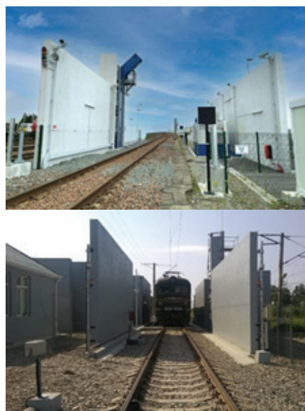
Slika 1. Primeri dva postrojenja za rendgensko skeniranje vozova
