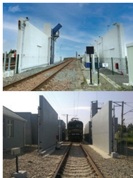
Slika 1. Primeri dva postrojenja za rendgensko skeniranje vozova
