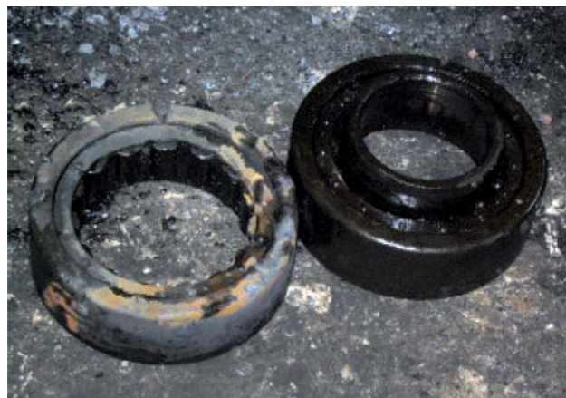
Slika 5. Prikaz oštećenog ležaja (levo) i neoštećenog (desno) (Izvor: SI CIP [2])
