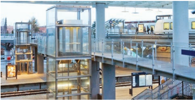
Slika 3. Primena stakla na železničkoj stanici Flintholm, Copenhagen [16]
