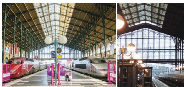
Slika 2. Kombinacija prirodnog dnevnog svetla i veštačkog osvetljenja na železničkoj stanici Gare du Nord, Pariz [15]
