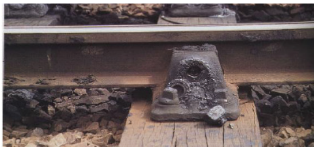
Slika 16. Polomljen stalak
