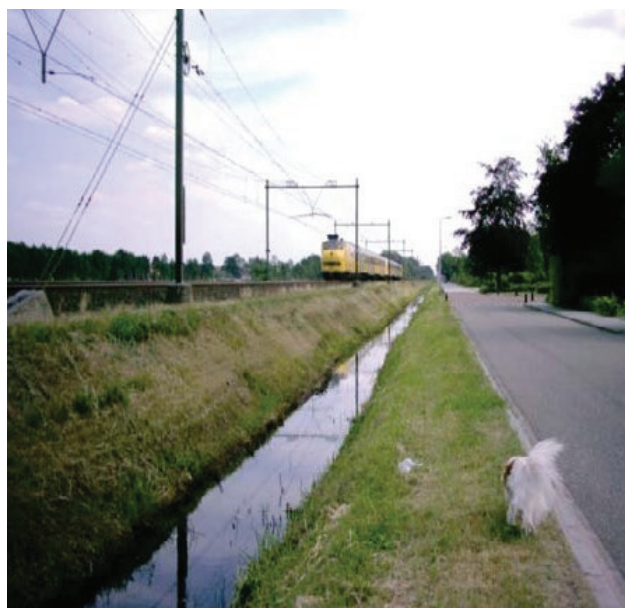
Slika 6. Primer postavljanja rova sa vodom duž železničke pruge radi sprečavanja širenja vibracija [5]
