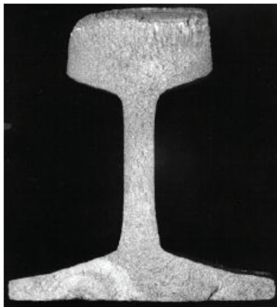
Slika 2. Poprečna pukotina koja počinje od korozivne jame na donjoj strani stope
