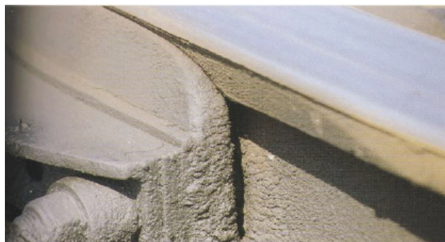
Slika 11. Trošenje glave glavne šine menjalice skretnice od prilepljivanja jezička [4]
