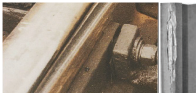
Slika 15. Jezičak sa oštrom gaznom ivicom
