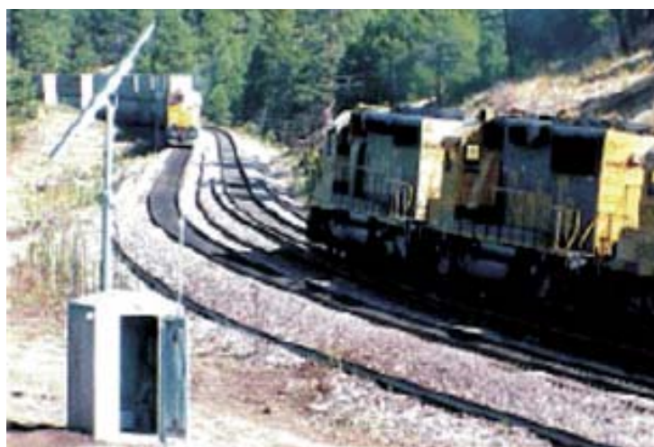
Slika 5. Mjerna mjesta deformacija u „S” krivinama [7]
